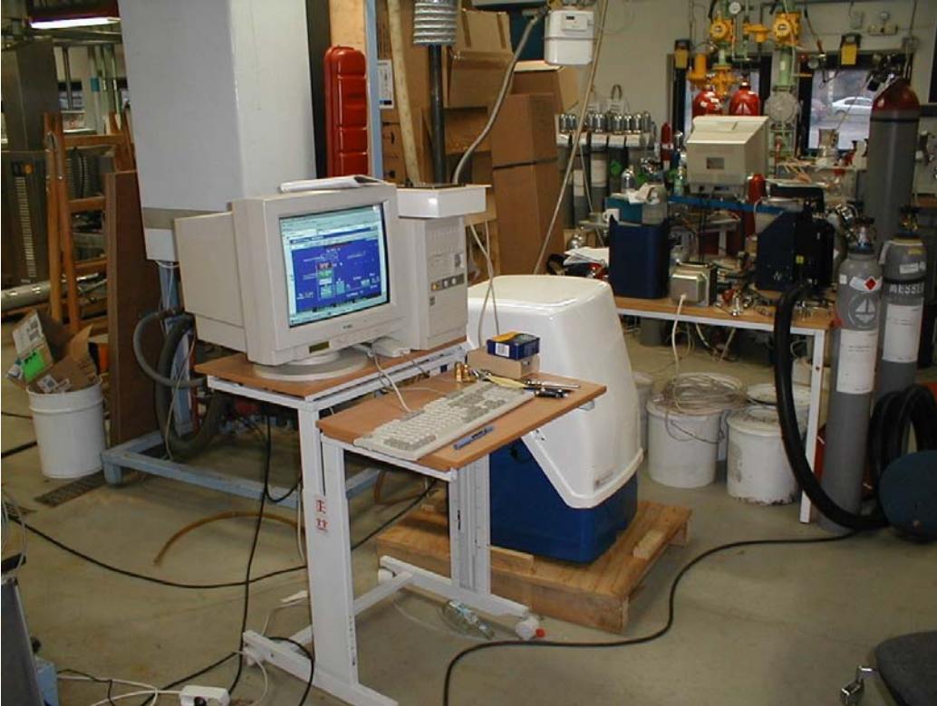
Figur 2: Lille Stirling-motorbaseret kraftvarmehenhed under afprøvning i DGC's laboratorium (WhisperGen)
