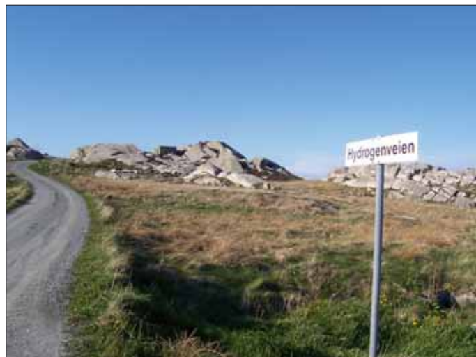
For enden af Hydrogenvejen ligger vind-og elektrolyseanlægget.
