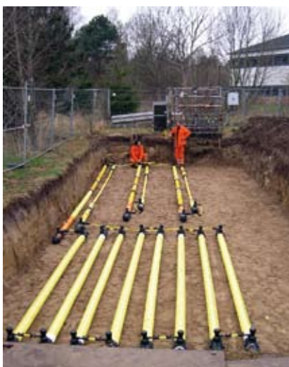
Nedlægning af plast testrør.
