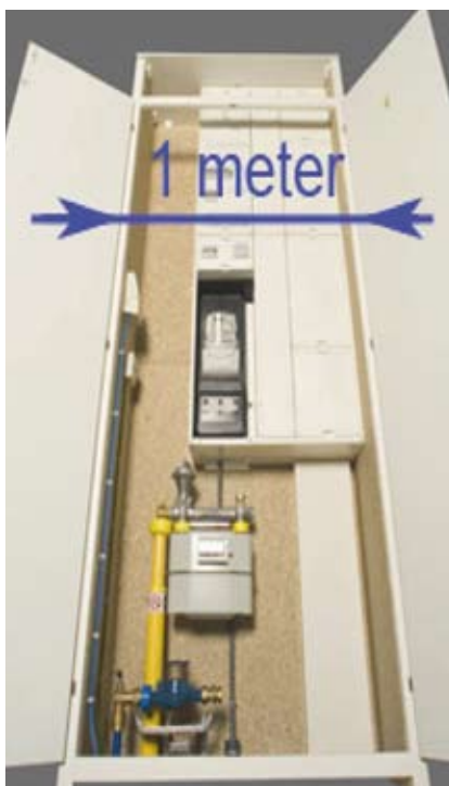
Et typisk indendørs fælles målerskab i Holland
