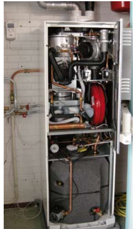
Ariston mikrokræftvarme demo-unit med varmtvandsbeholder.
