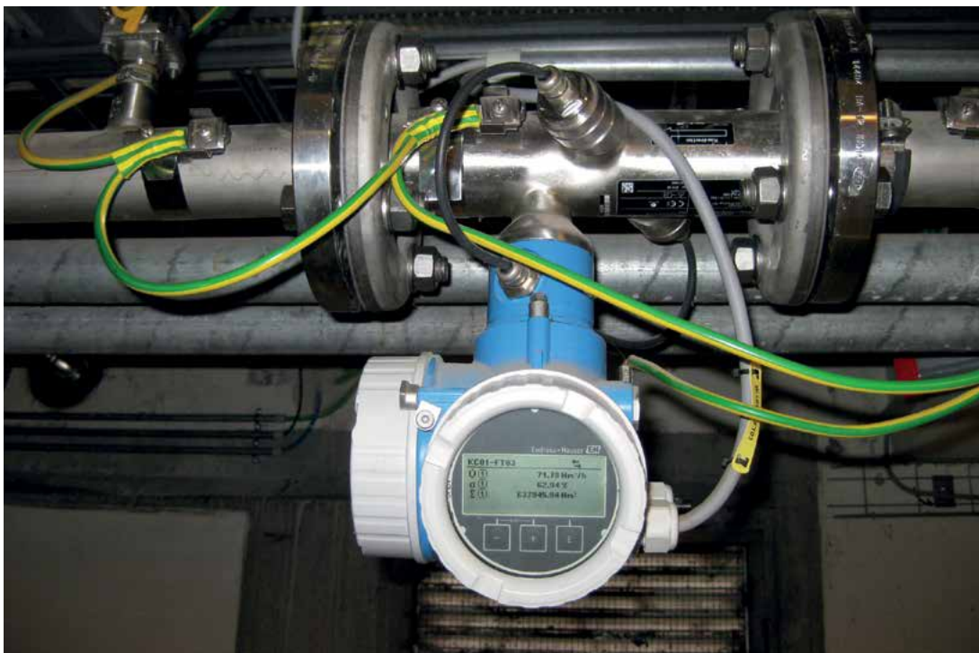
Eksempel på gasmåler der også måler og viser metanindhold i gassen.
