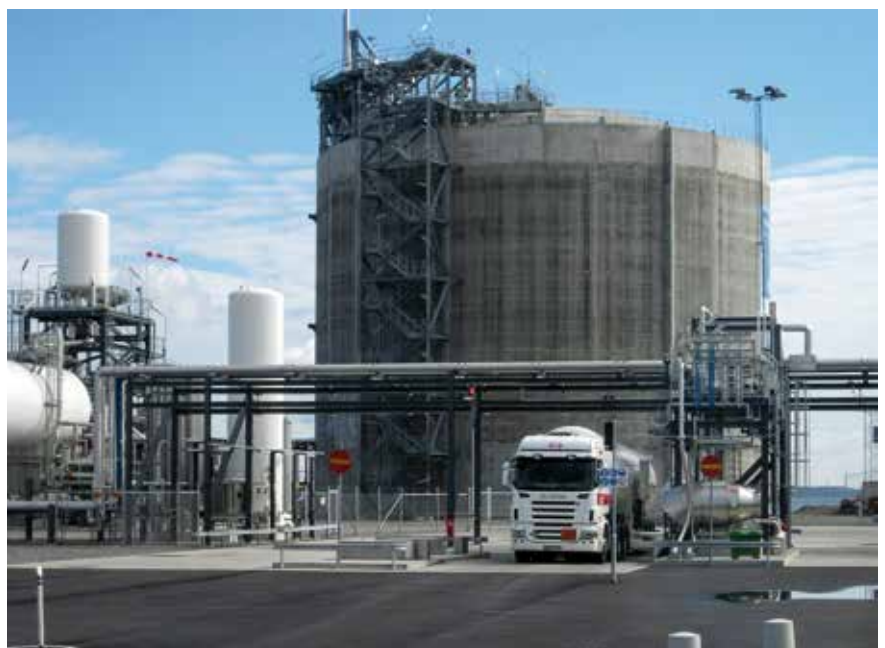
LNG-tank i Nynäshamn på 20.000 m 3 og lastbil til transport af LNG bl.a. til Stockholm. (Foto: Jan de Wit, DGC)
