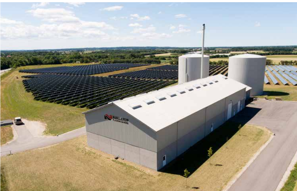
Solvarmeanlægget er placeret ved værket i Hjøllerp, hvor halmkedlen også er placeret. Den ny varmepumpe er installeret i Klokkeholm.
