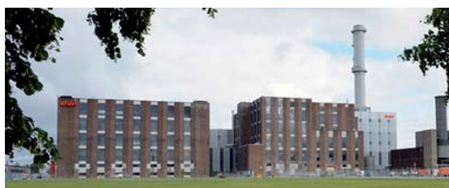
Öresundsverket i Malmö
